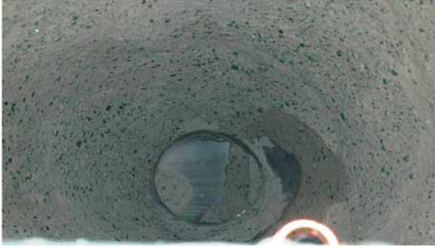
Fotoğraf 1. Fırın silosu içerisinde baca oluşumu
