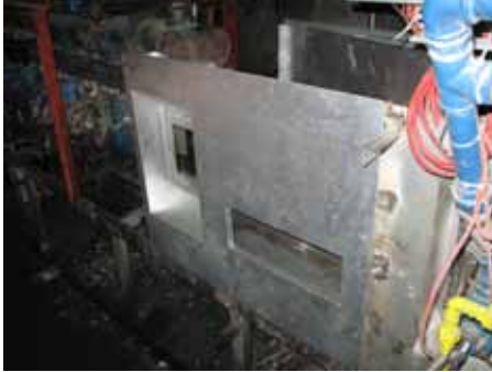
Şekil 9. Yakma Zonları çıkışına 1 adet yeni zon eklenmesi
